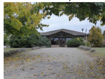
Restaurant en extension du centre-bourg – Puymiclan
