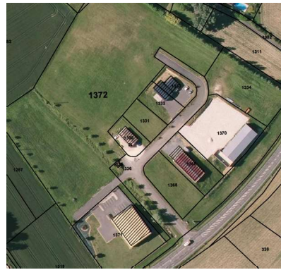
Vue aérienne de la zone d'activités
